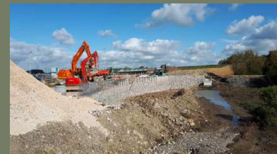
Mise en place des gabions pour la création du mur de soutènement
