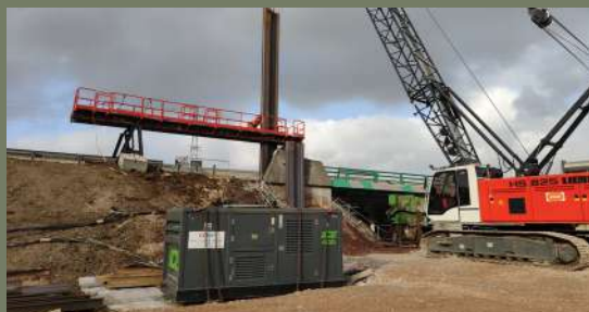
Mise en place des palplanches pour l'élargissement de l'ouvrage
