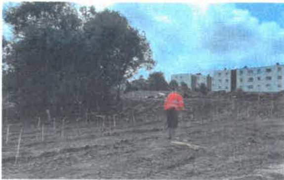
Décapage et reimplantation des points magnétiques
